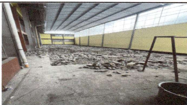
Foto 3: Demolición de piso en mal estado
