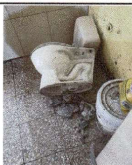
Foto 5: Reparación de sanitarios
