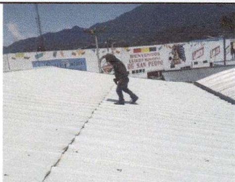
Foto1: Sustrucción de lámina
