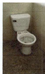
Foto 6: Reparación de accesorios de sanitarios
